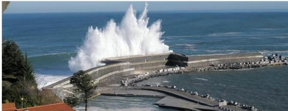
Brise lame integrant une colonne d'eau oscillante (OWC) de Mutriku. (Crédit : http://travelmetal )
