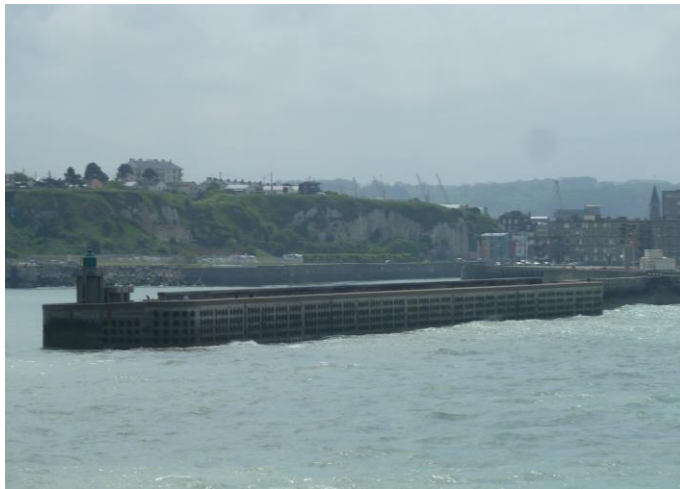
Digue en caisse Jarlan de Dieppe
